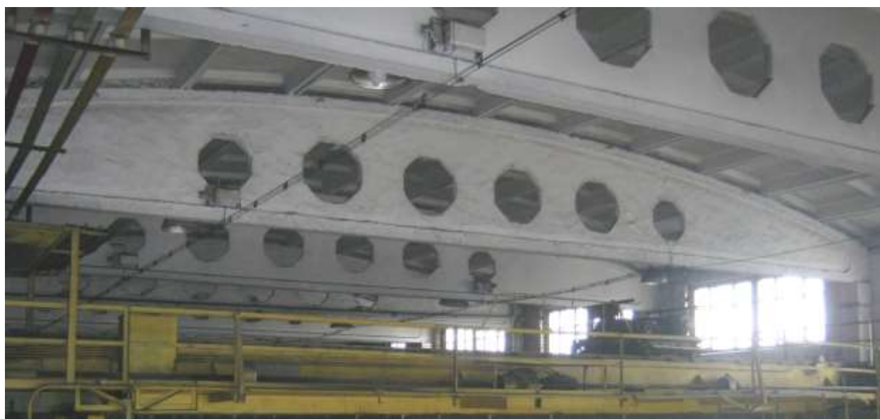
Рис. 20. Общий вид 18-ти метровой двутавровой облегченной балки.
