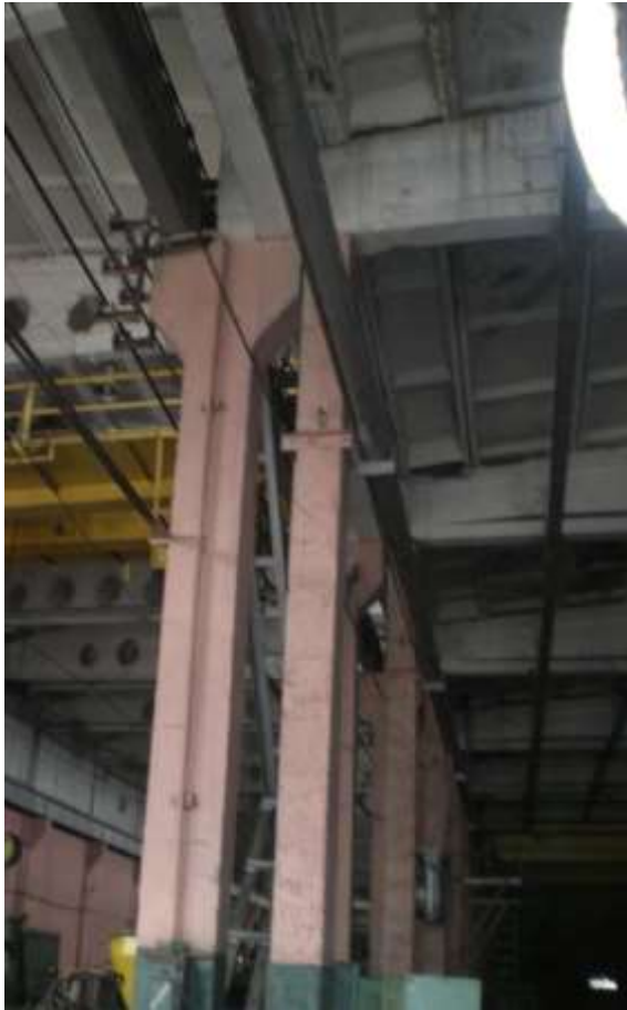
Рис.16. Крайние колонны на стыке двух строительных объемов здания.
