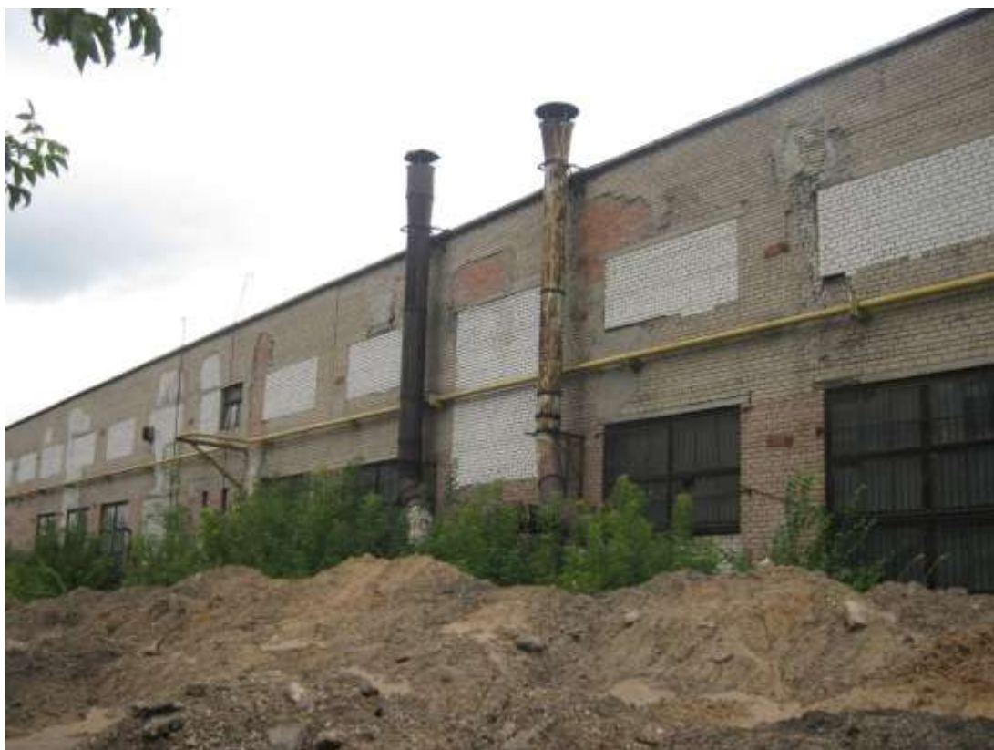
Рис. 2. Общий вид дворового фасада
