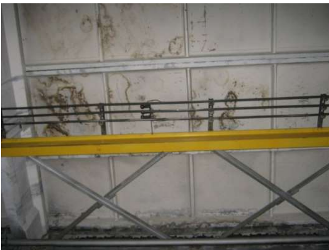
Рис. 36. Общий вид металлических крестовых связей по оси М.
