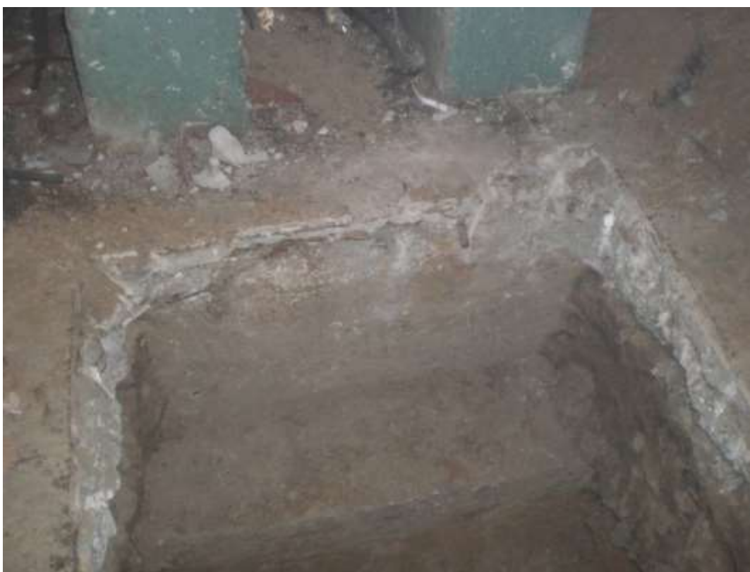
Рис.8. Результаты вскрытия шурфов для определения конструкции фундаментов под колонны среднего ряда по оси Г в деформационном шве.
