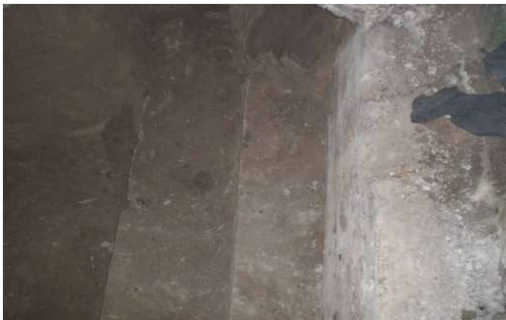
Рис.6. Результаты вскрытия шурфов для определения конструкции фундаментов под колонны среднего ряда по оси М.
