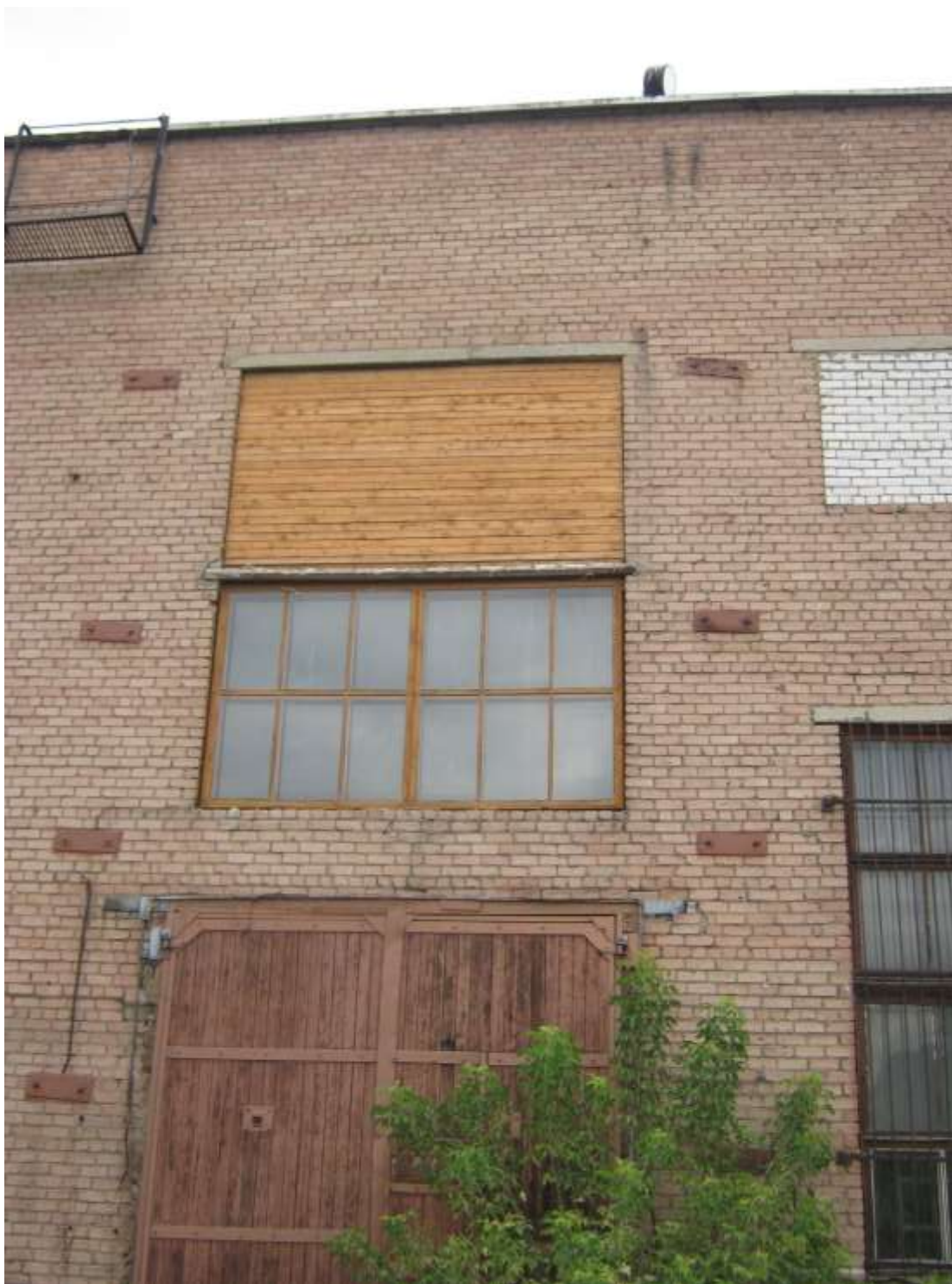
Рис.14. Усиление стен здания по оси А.
