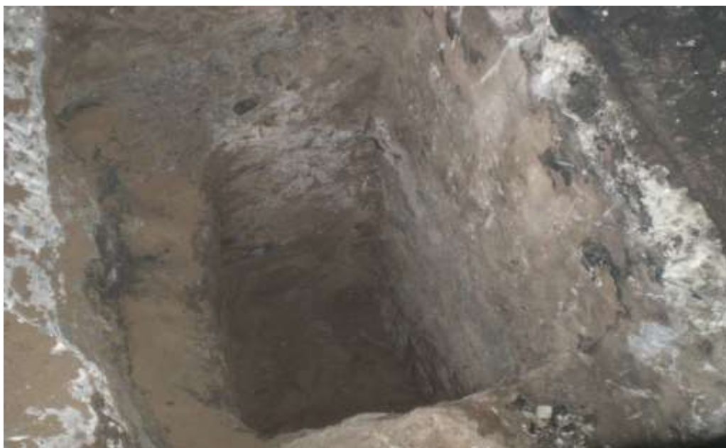
Рис.5. Результаты вскрытия шурфов для определения конструкции фундаментов под колонны крайнего ряда по оси Р.
