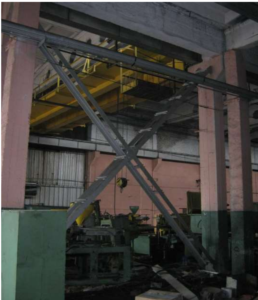
Рис. 34. Общий вид металлической крестовой связи в осях 24-25 по оси Ж.
