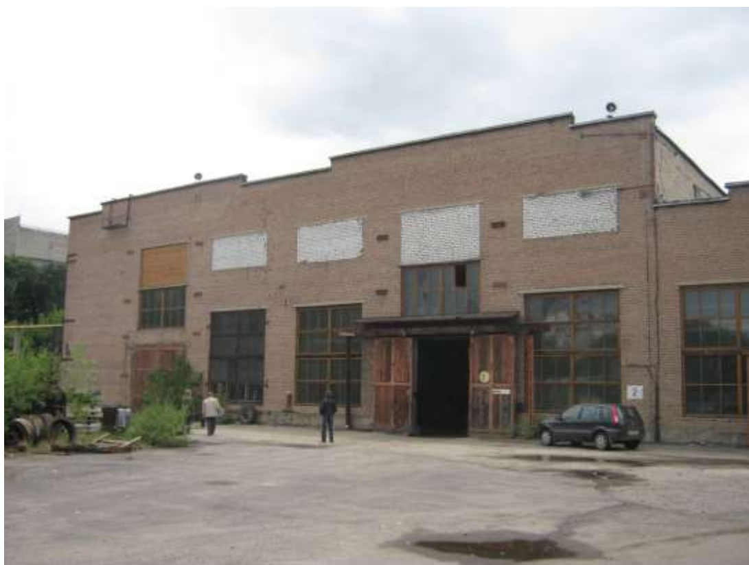
Рис. 4. Фрагменты общего вида торцевого фасада со стороны завода «Ярполимермаш»
