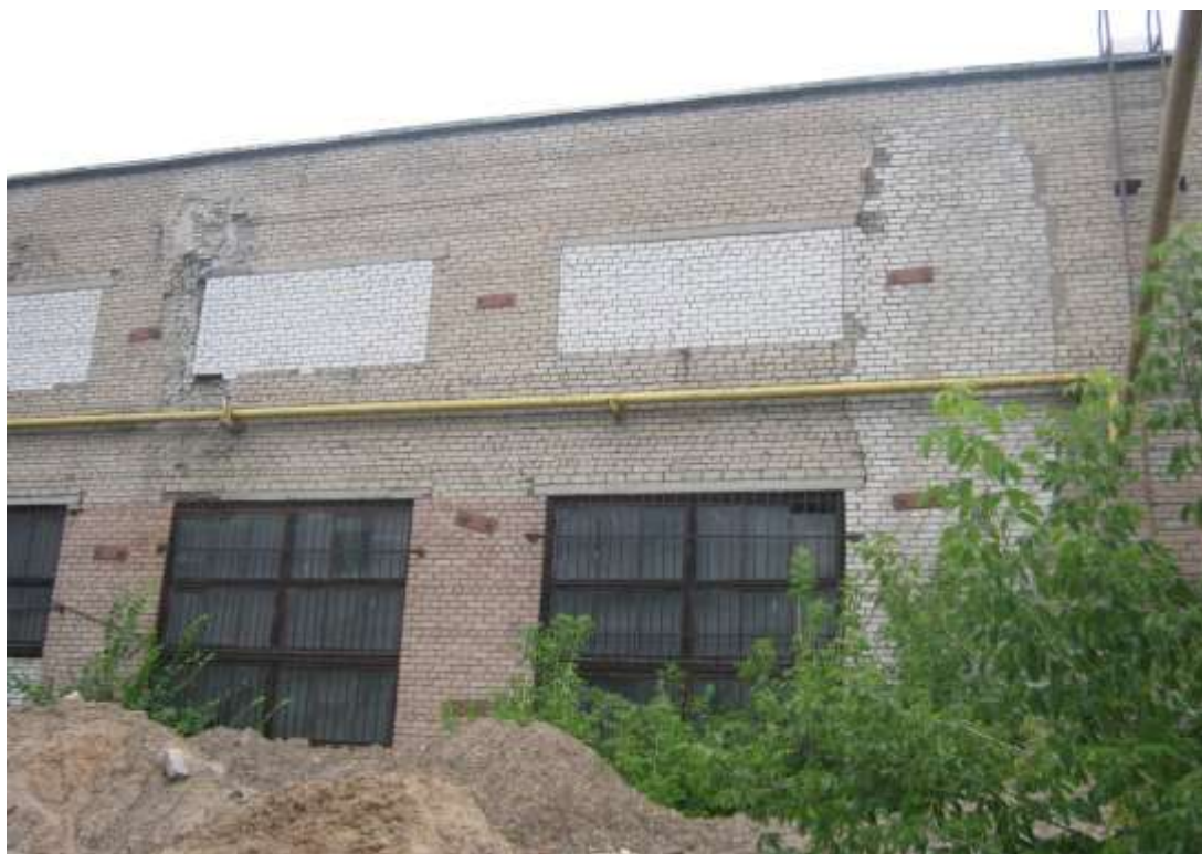
Рис.15. Закладка оконных проемов по оси А.
