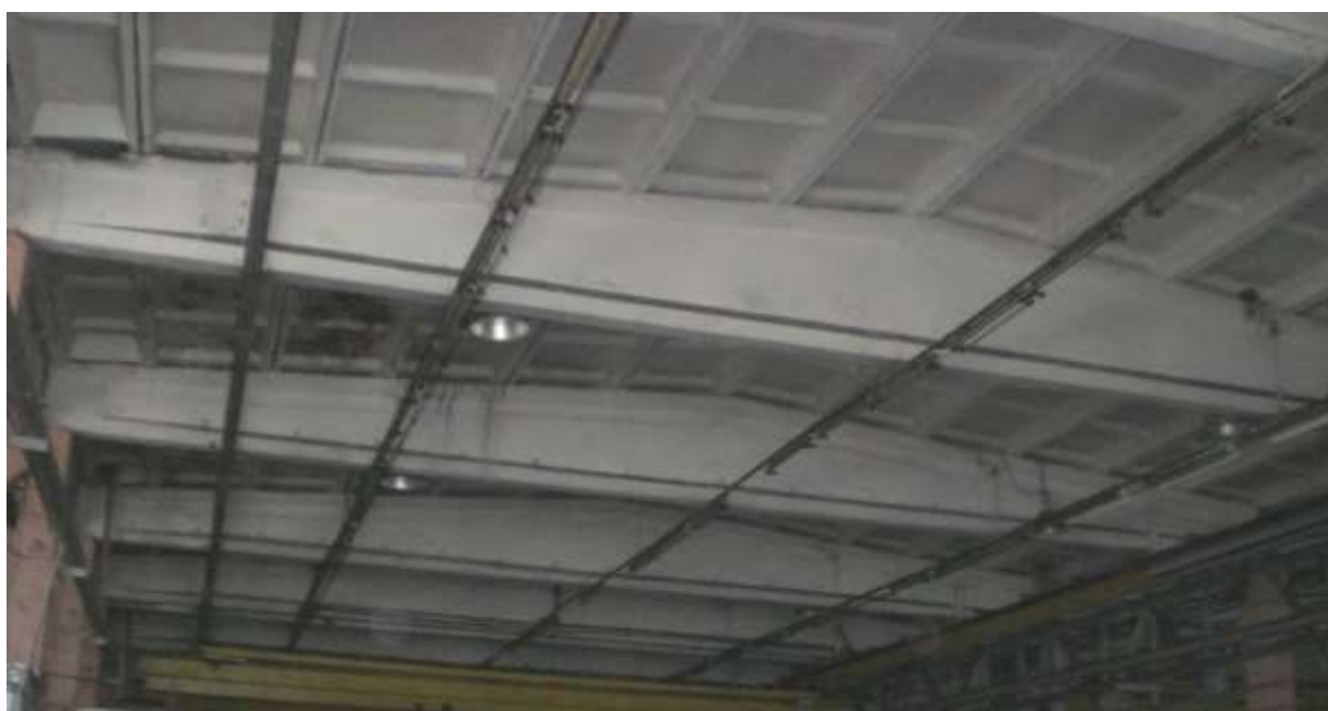
Рис. 20. Общий вид 18-ти метровой двутавровой облегченной балки.
