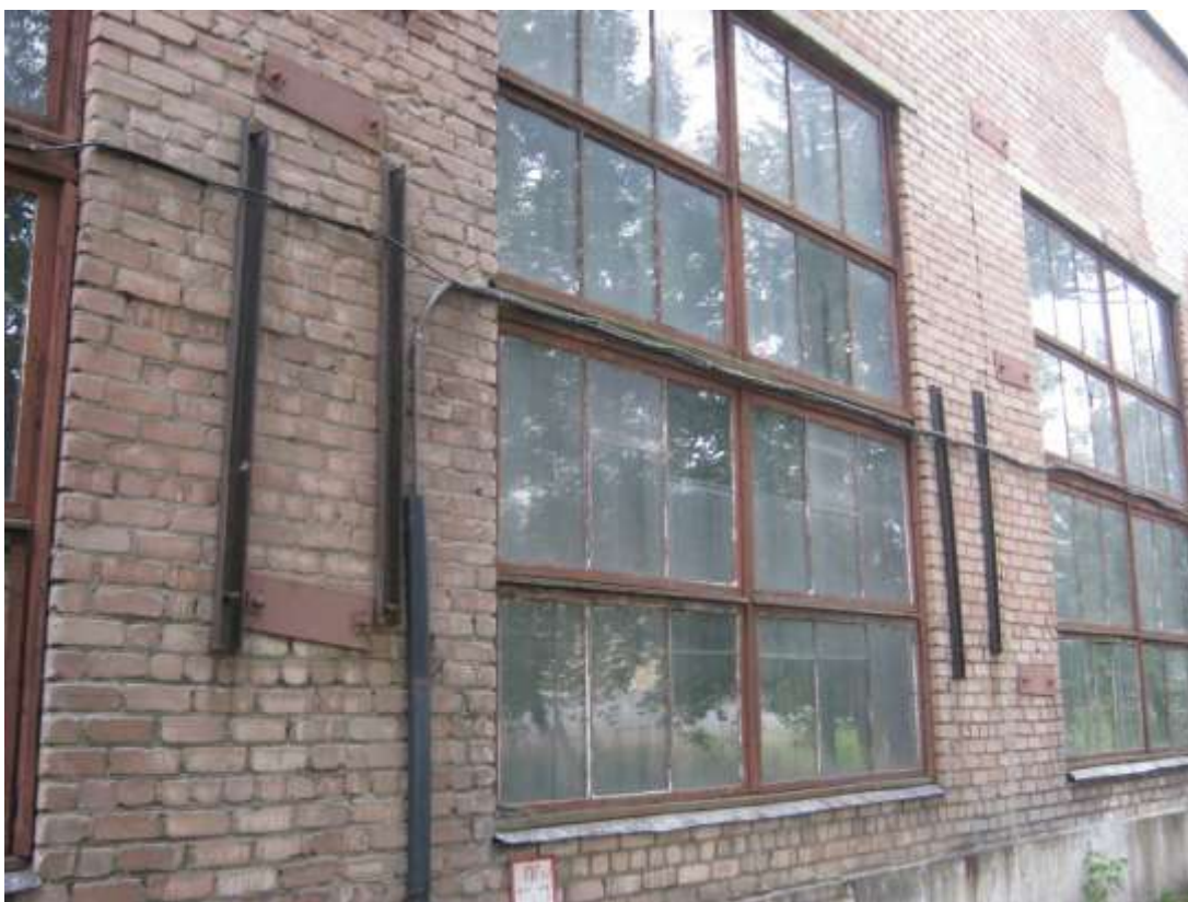
Рис.13. Усиление простенков здания по оси Р.
