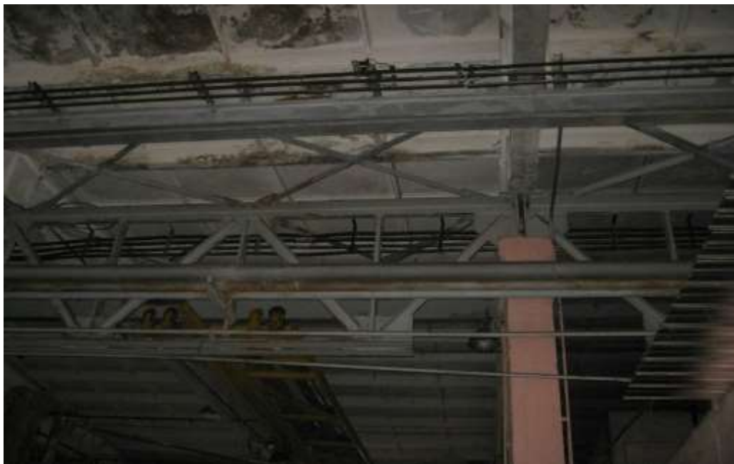
Рис.18. Общий вид средней колонны по оси М с опиранием на нее стропильных балок и под-стропильных ферм.
