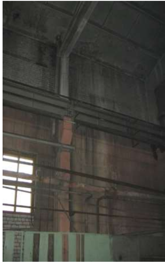
Рис.17. Общий вид крайней колонны по оси А
