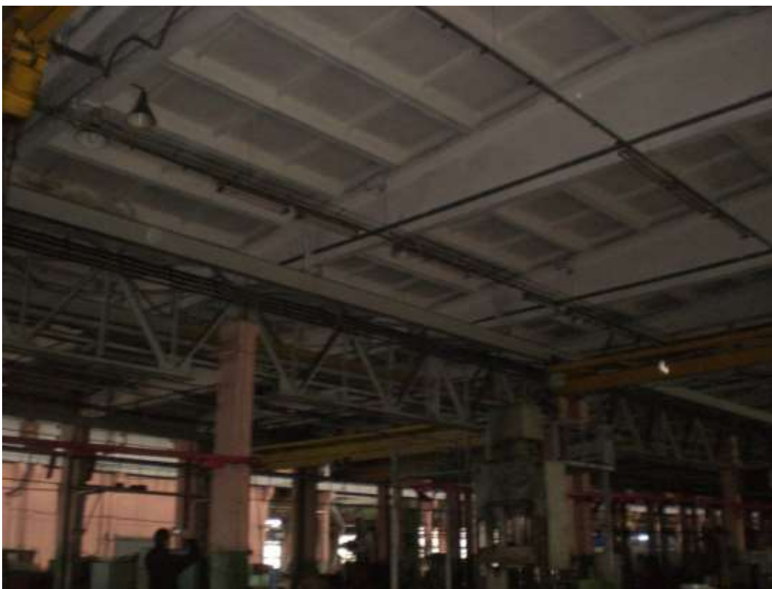
Рис. 25 ФРАГМЕНТЫ ОПИРАНИЯ ПОДСТРОПИЛЬНЫХ ФЕРМ НА КОЛОННУ КАРКАСА.
