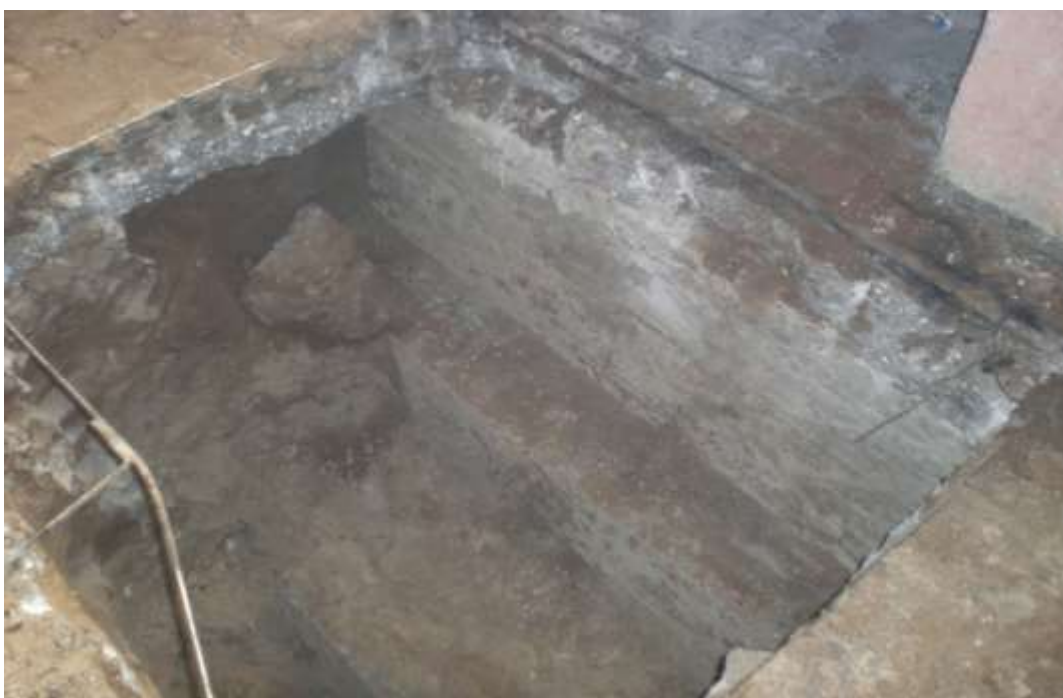
Рис.10. Результаты вскрытия шурфов для определения конструкции фундаментов под колонны крайнего ряда по оси А.
