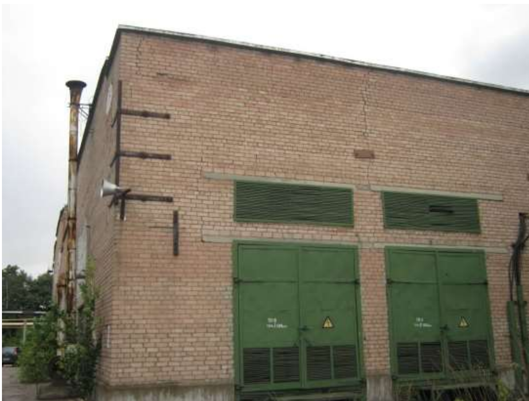
Рис.12. Усиление угла здания в осях Р-27.
