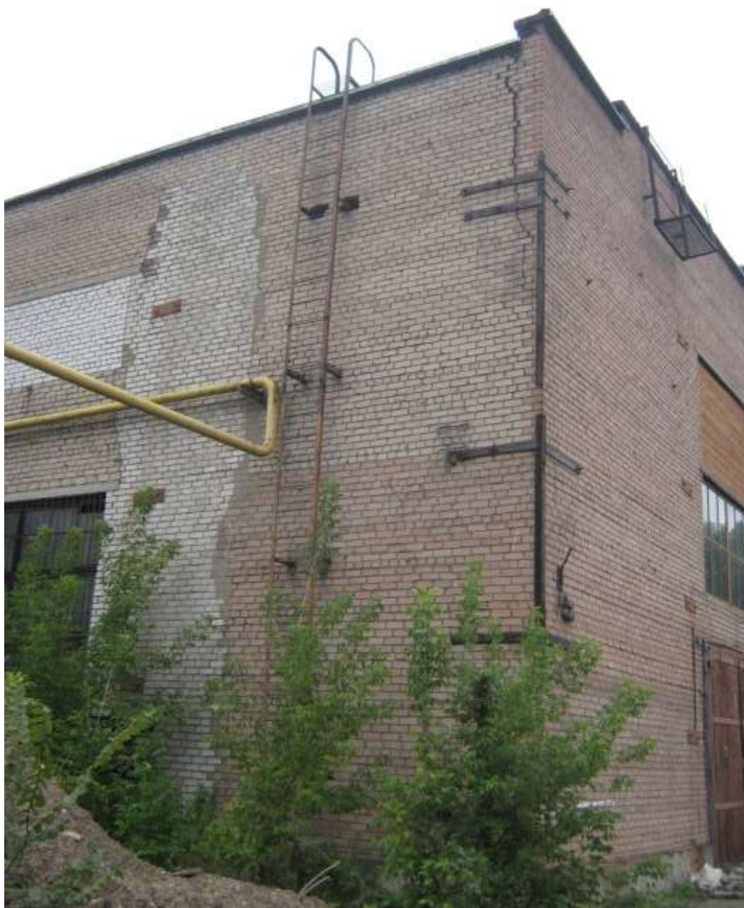
Рис.11. Усиление угла здания в осях А-27.
