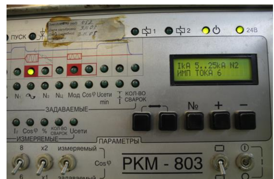
Установка на регуляторе сварки длительности импульса тока 6 периодов
