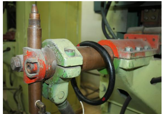
Датчик тока установлен на нижнем хоботе вторичного контура
