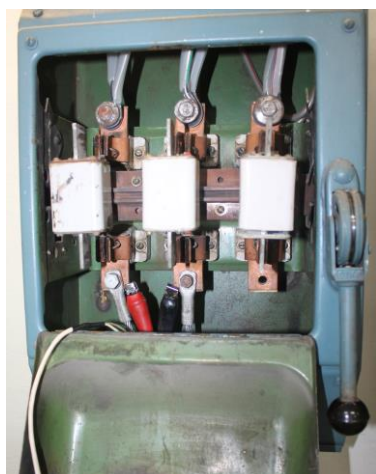
Датчик первичного напряжения подключен к питающей сети
