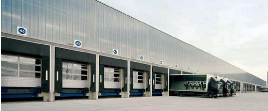
Рис. 3. Расположение постов приемки товара (ворот) для автотранспорта приходящего под разгрузку
